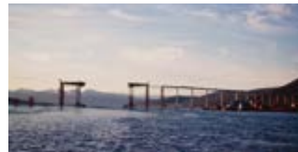
Tromsøbrua var den første i Norge som ble bygget etter fritt-ram-metoden. (ALLE FOTO OVER: PERSPEKTIVET MUSEUM)
