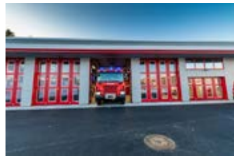
Nødetater på Finnsnes: Den nye brannstasjonen på Finnsnes ble ferdigstilt i 2019. Kontraktssummen var 42 millioner.
