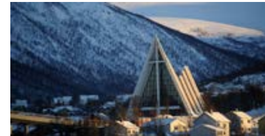
Ishavskatedralen, opprinnelig fra 1965, ble i 2008 rehabilitert. Kontraktssummen var 13,8 millioner.
