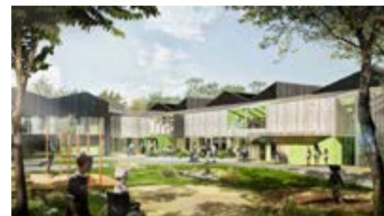
BREEAM: Sommerlystvegen barne- og avlastningsboliger ferdigstilles i 2022, og er av byggherren Tromsø kommune bestilt til å tilfredsstill BREEAM-sertifisering.
