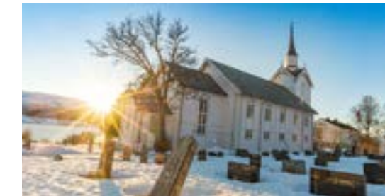
Kvæfjord kirke, opprinnelig fra 1867, ble i 2017 rehabilitert. Kontraktssummen var 30 millioner.
