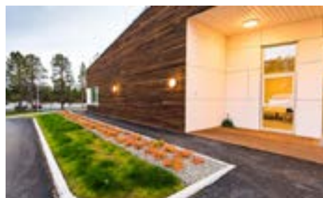
Avlastningsboligene for barn og unge i Alta ble åpnet i 2017. Kontraktssummen var 24 millioner.
