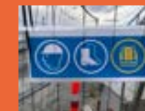
Anleggsområdet er avsperrt, og skiltet med hvilket sikkerhetsutstyr som kreves. Her på SalMar-anlegget.
