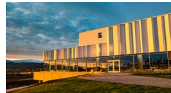
Tromsøbadet ble åpnet i 2018. Kontraktssummen for Bjørn Byggs del var 300 millioner.
