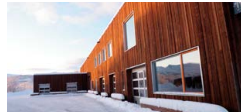
I 2009 ble det nye undervisningsbygget for byggt tekniske fag åpnet ved Kvaløya videregående skole i Tromsø. Kontraktssummen var 35,5 millioner.
