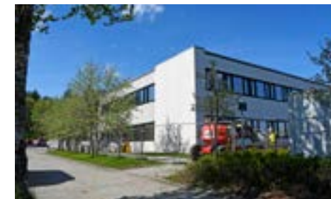
Naturfagbygget ble satt opp av Nils Meland, og var det første bygget som ble reist på Campus Breivika. Dette skjedde i 1974, to år etter at de første studentene kom til Tromsø. I 2020 startet Bjørn Bygg renovering av dette bygget.
