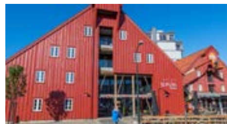
Rehabilitering er mer miljø- og klimavennlig enn nybygging. Holmboebryggene i Tromsø ble opprinnelig bygget i 1830 og ble renoveret i 2008. Kontraktssummen var 37,6 millioner.
