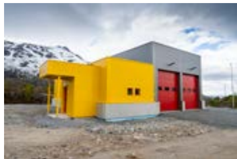
Nødetater på Senja: Den nye branngarasjen på Stonglandseidet ble ferdigstilt i 2020. Kontraktssummen var 7,7 millioner.
