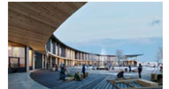
Kautokeino skole er planlagt åpnet i 2022, med en kontraktssum på 207 millioner.
