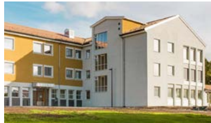
Åsgård sykehus ble bygget av Meland på 50-tallet. Bjørn Bygg renoverte Bygg 7 ved UNN Åsgård i 2016. Kontraktssummen var 47,4 millioner.
