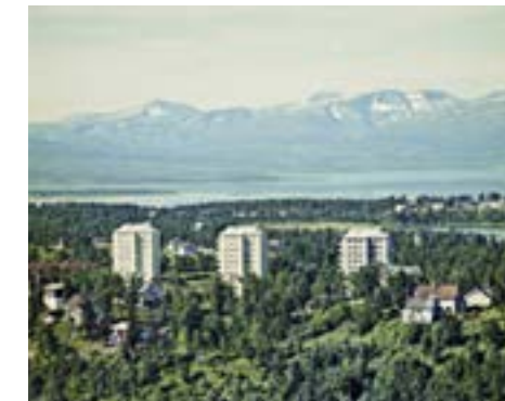
Myrengblokkene på toppen av Tromsøya ble bygget av Nils Meland AS, og regnes av mange som den første store feltutbyggingen i Tromsø. Blokkene ble bygget ved hjelp av «glideforskaling», noe som vakte oppsikt, ettersom dette ikke var en metode som ikke var vanlig å benytte ved bygging av boliger.
