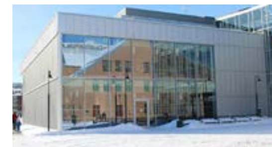
I 2016 utførte Nilsen & Haukland påbygging og delvis ombygging på Campus Harstad for UiT. Kontraktssummen var 22 millioner.
