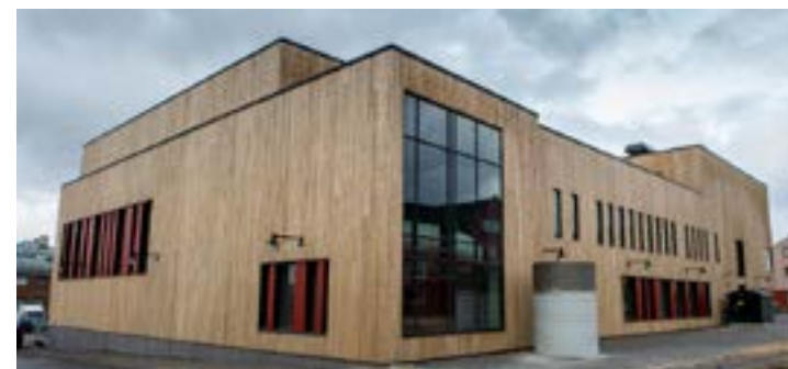
Vardø flerbrukshus, ferdigstilt i 2014 til en kontraktssum på 133 millioner. Jobben ble gjennomført i samarbeid med Nilsen & Haukland. Bygget består av svømmehall, kulturhus og idrettshall.
