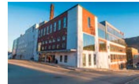
Kunstakademiet ble en del av UiT i forbindelse med sammenslåingen med Høgskolen. De renoverte lokalene sto ferdig i 2013. Kontraktssummen var 46 millioner.
